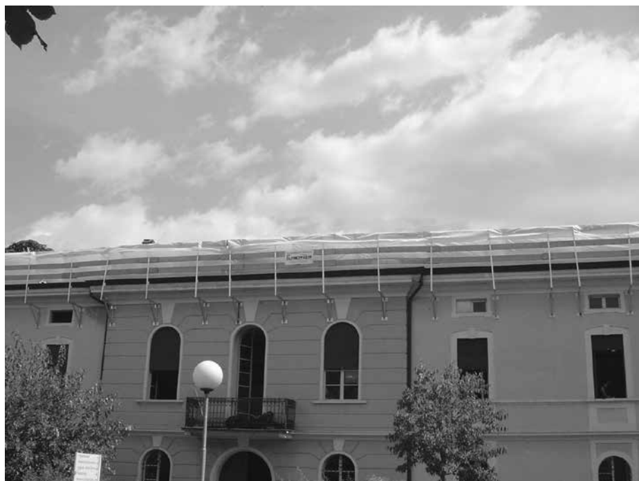
Sistemi provvisionali di protezione bordi tetti
