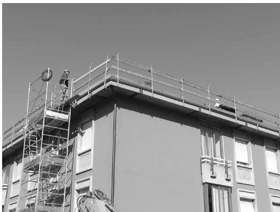
Sistemi provvisionali di protezione bordi tetti
