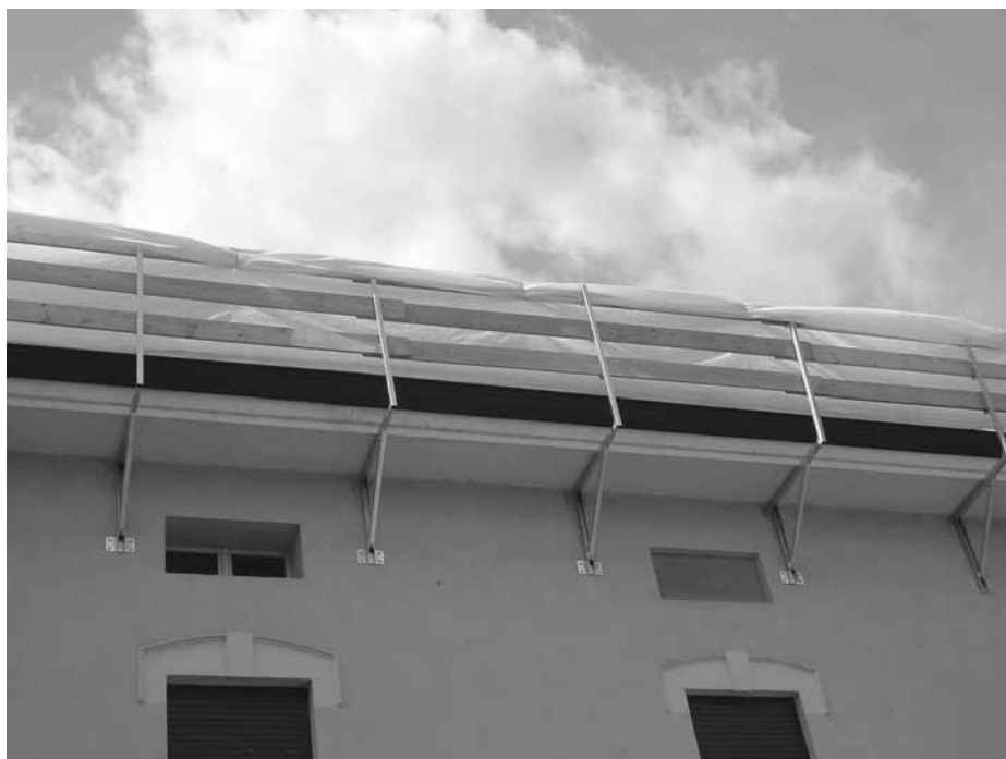
Sistemi provvisori di protezione bordi tetti
