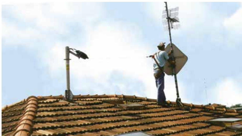
Utilizzo DPI, arresto caduta con punto di ancoraggio puntiforme.
